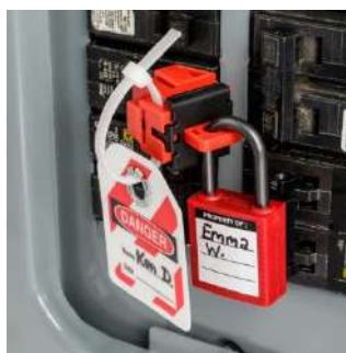
Ejemplo Sistema Bloqueo Interruptores
